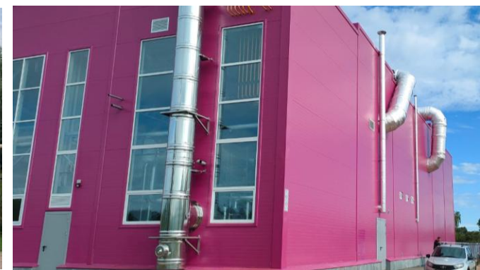
ООО «ТКЛ ГРУПП» Производственное здание текстильного предприятия Дата разрешения на ввод объекта в эксплуатацию: 23.12.2025 г.
