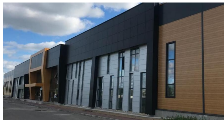
ООО «СУРТЕКС РОДНИКИ» 2-й Этап Текстильного предприятия Дата разрешения на ввод объекта в эксплуатацию: 18.07.2025 г.
