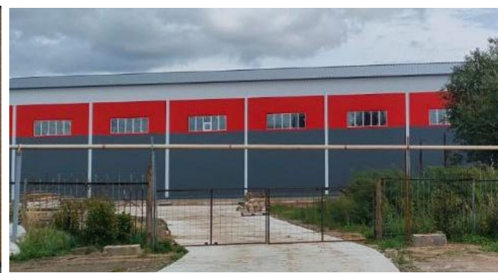
ООО «КМ-ТЕХНО» Производственное здание Дата разрешения на ввод объекта в эксплуатацию: 12.12.2025 г.
